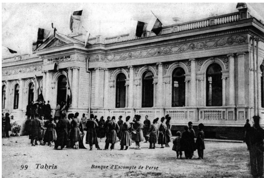
نمای بیرونی بانک استقراضی در تبریز [۱۳۱۰۳۹-۲۲۷۵م]
